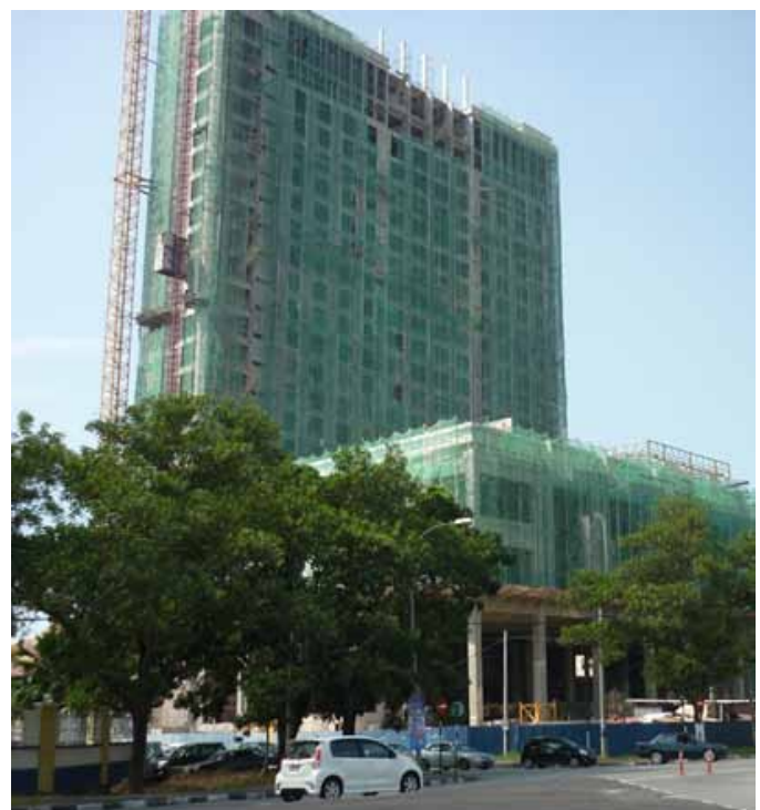
Light Hotel, Seberang Jaya
