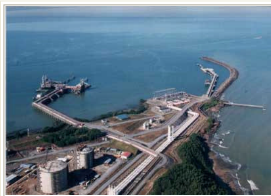
LPG, MLNG Jetties, Bintulu Port Area
