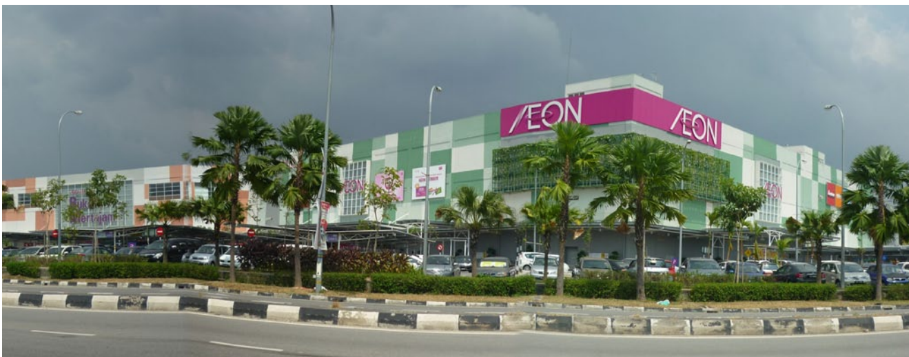
AEON Mall Alma in Bukit Mertajam, Seberang Perai
